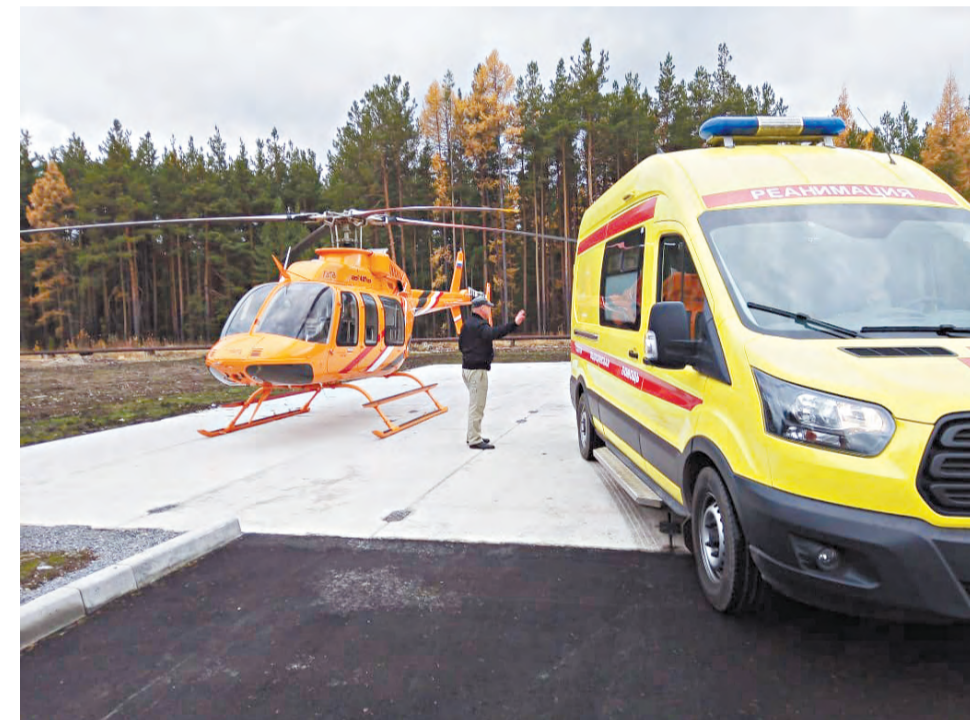
Вертолетная площадка в г. Реже.
