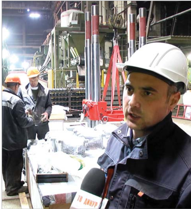
2019 год. Заместитель главного механика завода Анатолий Стремоусов – на монтаже нового гидравлического пресса на ПФУ второго цеха.
