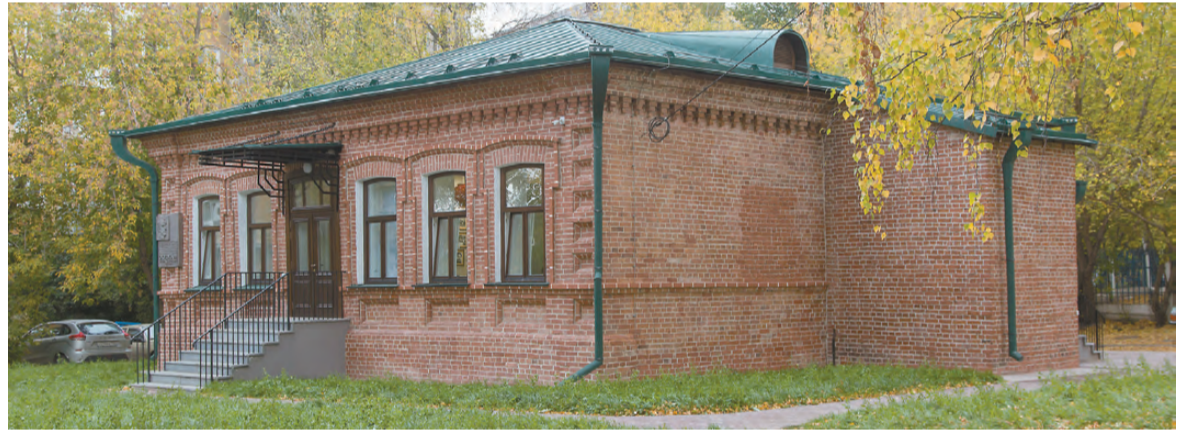
Так после реконструкции выглядит обновленный «Дом Окуджавы».
