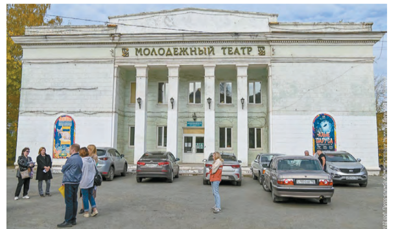
Здание с 85-летней историей давно требовало капитального ремонта.
