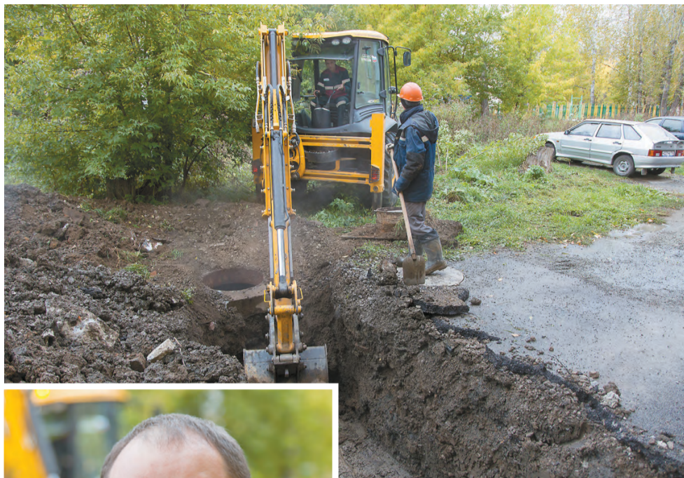
Подготовка к замене трубы горячего водоснабжения.
