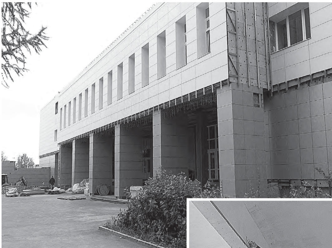
Завершается утепление фасада.
