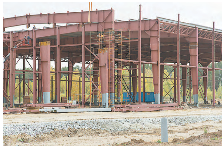
Монтаж производственного корпуса.
