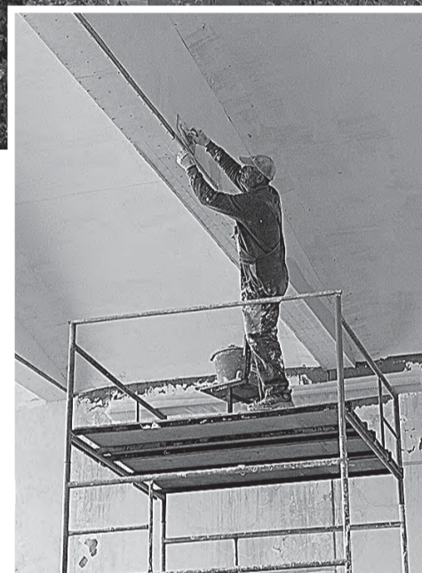
Ежедневно на стройплощадке трудятся более 30 рабочих.
