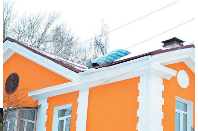
Крыша на доме №32 по улице Береговой: вид снаружи и внутри
