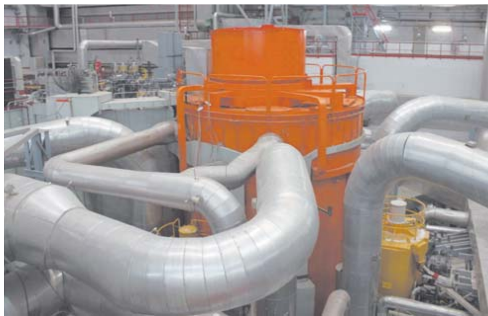
Самое сердце БАЭС — реактор на быстрых нейтронах четвёртого энергоблока. Его прозвали «паук». Есть также реактор-«ромашка»
