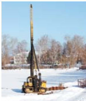
Сваебой установлен на верхнем бьефе
