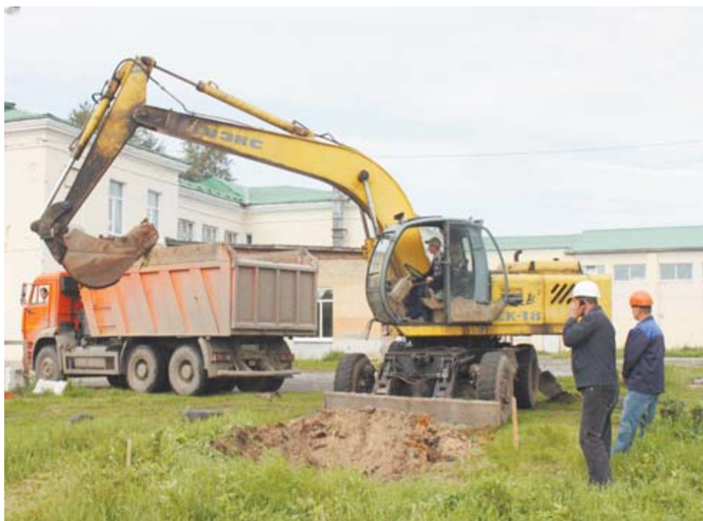
Строители роют котлован для будущего пристроя
