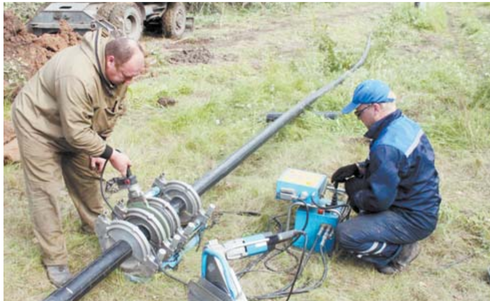
Рабочие «Газовых сетей» занимаются спайкой труб газопровода
