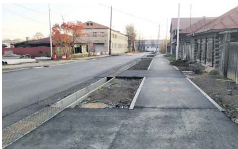
Улицу Фрунзе начали ремонтировать в 2021 году
