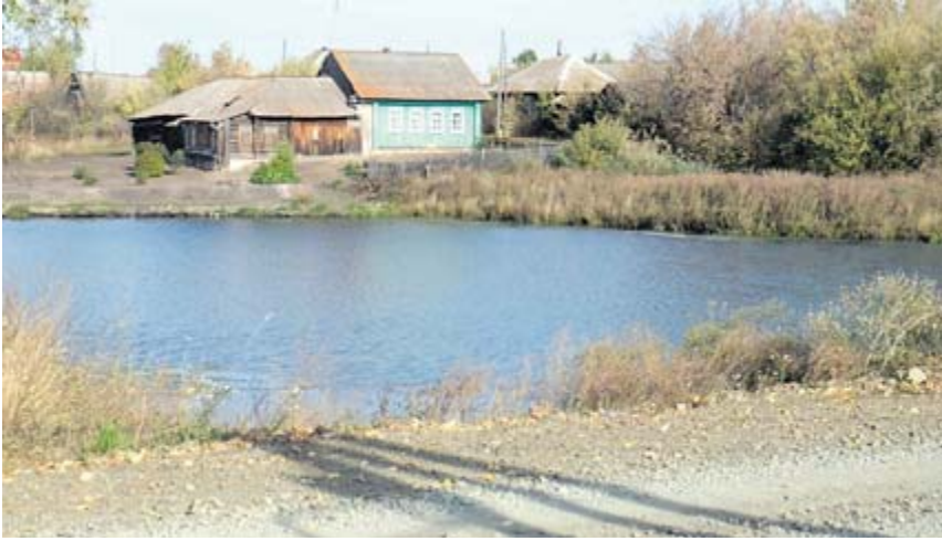
Плотина отремонтирована год назад
