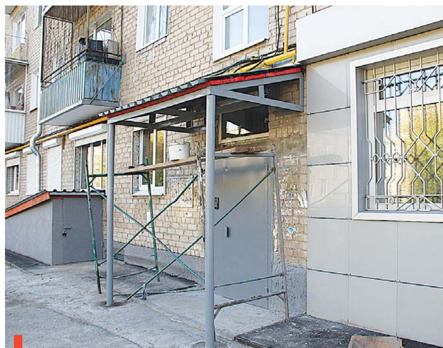
Заканчивается ремонт на доме №7 по ул. Гагарина
