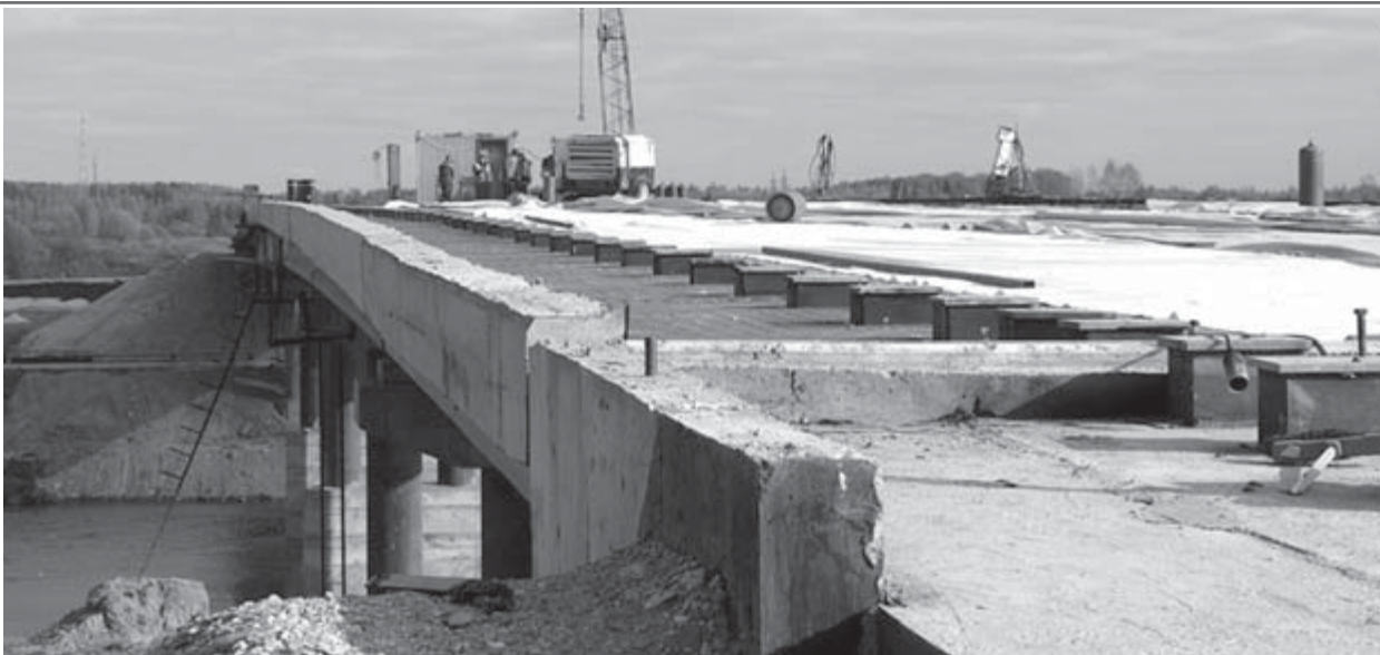
Большая часть работ уже выполнена
