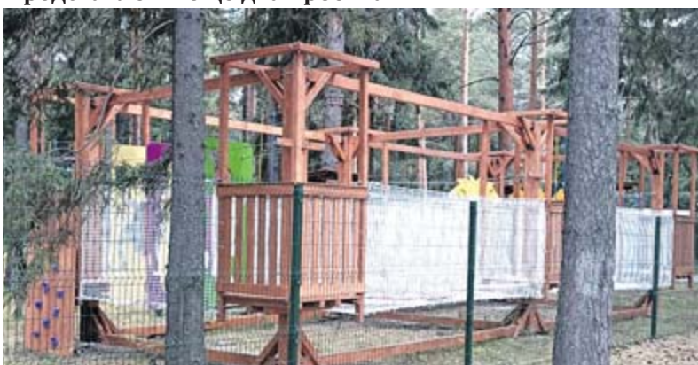
Работы почти завершены. Скоро открытие!
