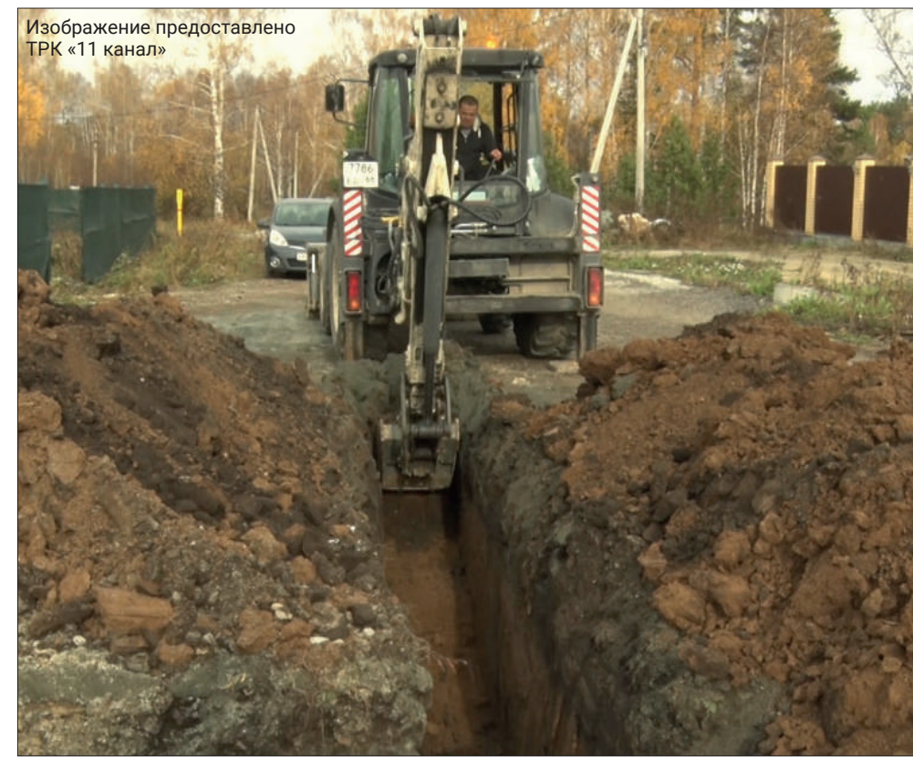
В зависимости от технических условий бригады компании «ГАЗЭКС» прокладывают газопровод по воздушной линии либо под землёй. На ул. Рябиновой в п. Красная Горка прокладывается подземный газопровод
