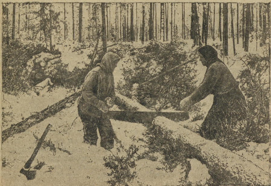
На заготовке леса. Раскряжевка хлыста
