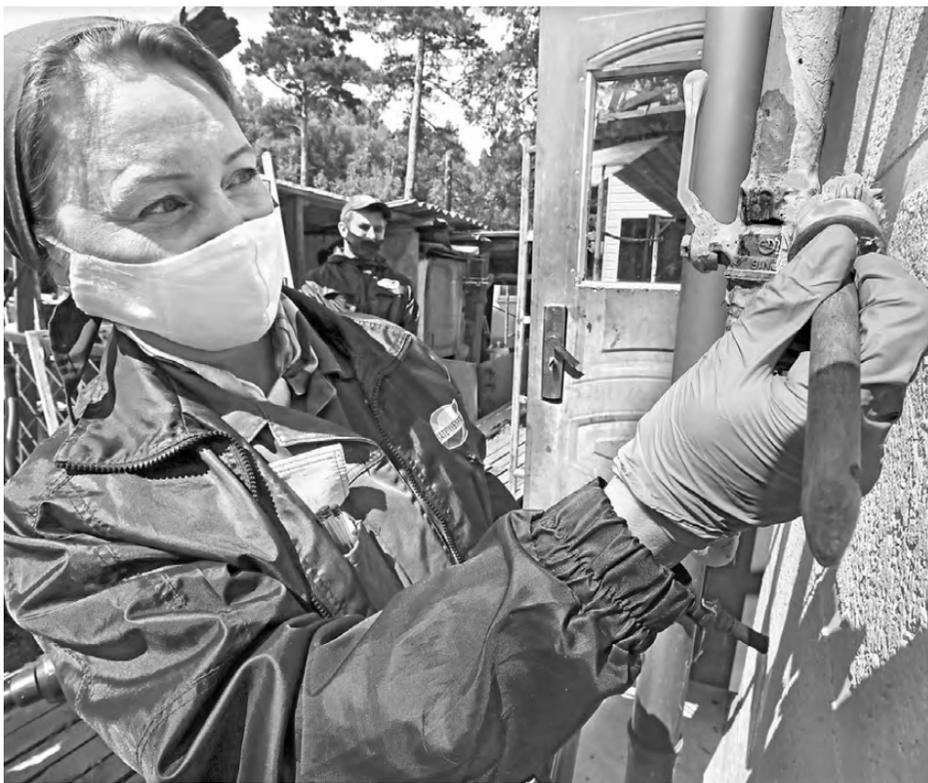
Обмыливание газовой трубы позволяет быстро определить, герметична ли резьба.
