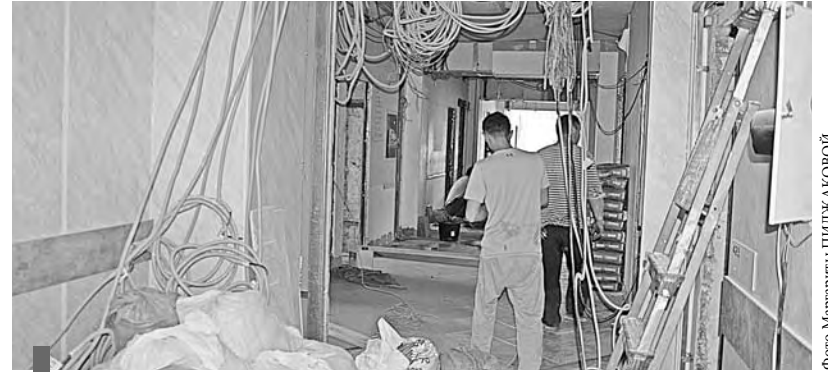
Ремонт в процессе
