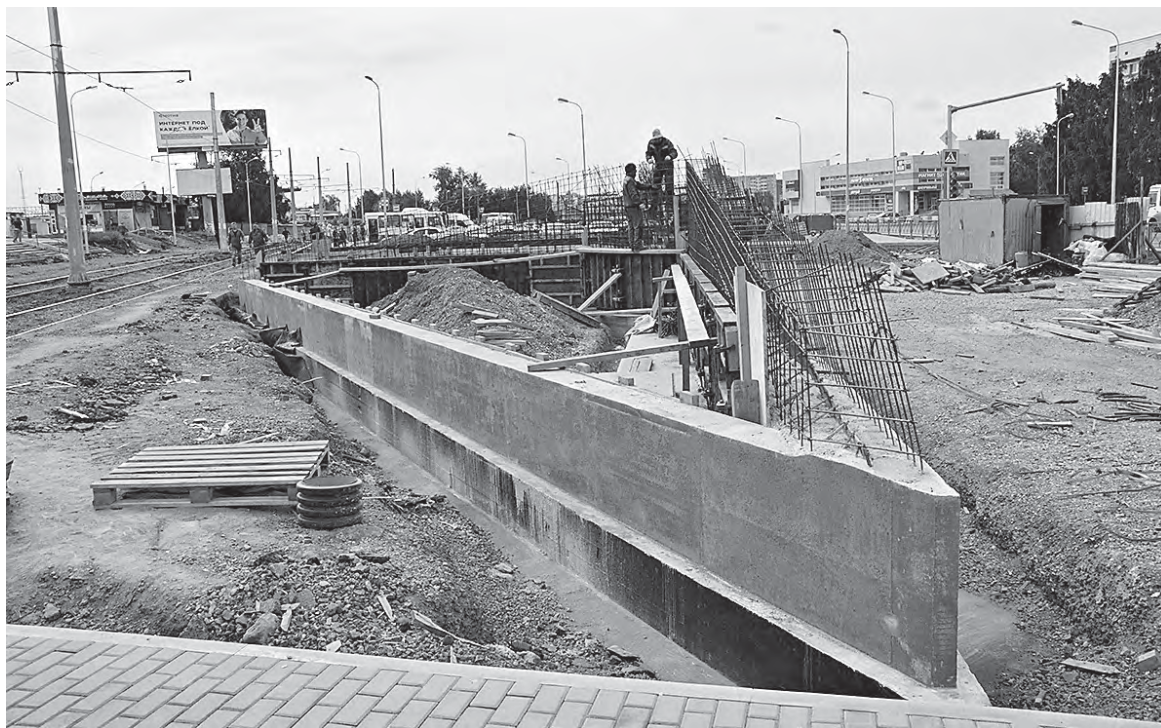
Арматурная сетка фундамента будущей стены.
