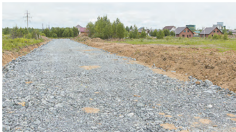
Дорога отсыпана скальным грунтом. На заднем плане – недавно построенные домики.
