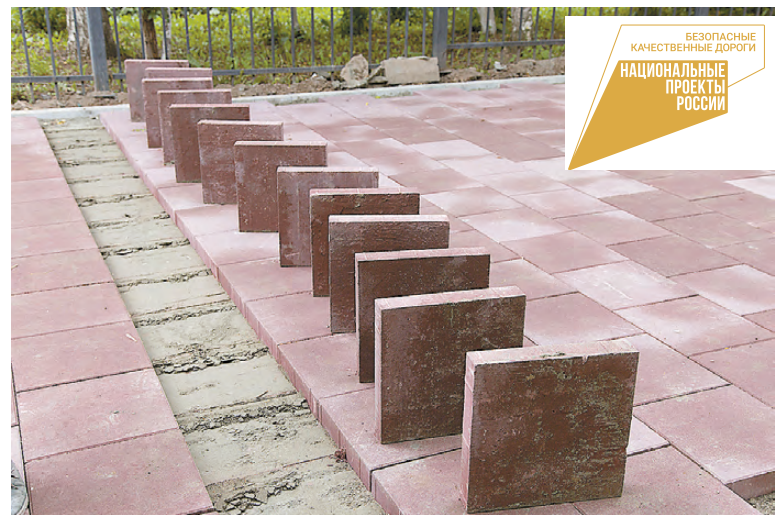
На тротуары укладывают специальную усиленную плитку размером 40x40 см.
