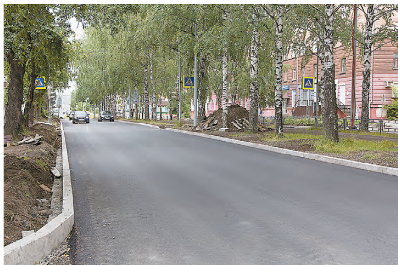
Дорожное полотно уже готово, уложены два слоя асфальта.
