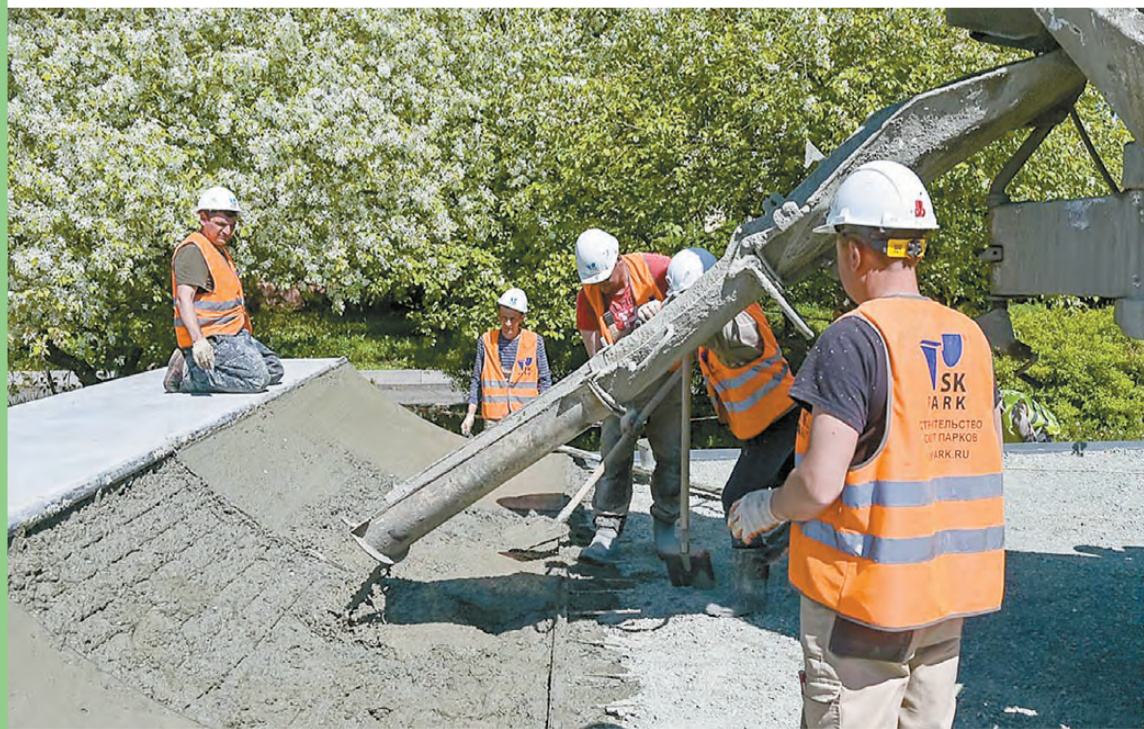
Заливают последние фигуры скейт-парка на Тагилстрое.
