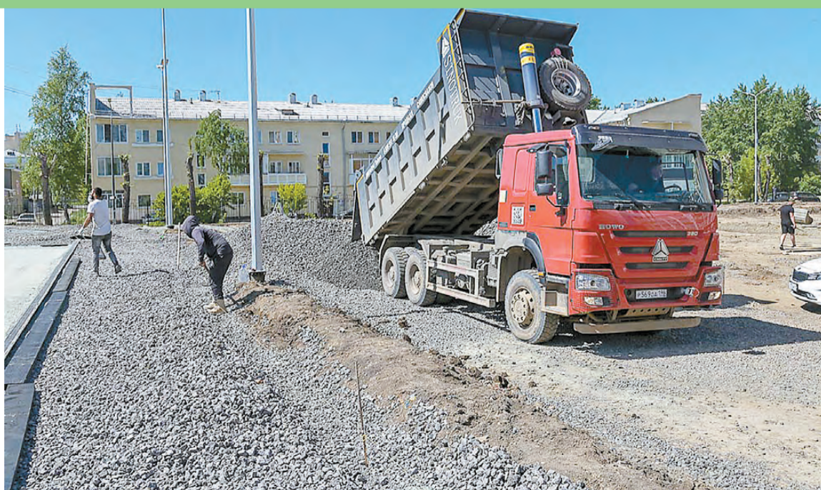
Вскоре рабочие приступят к укладке искусственного газона.
