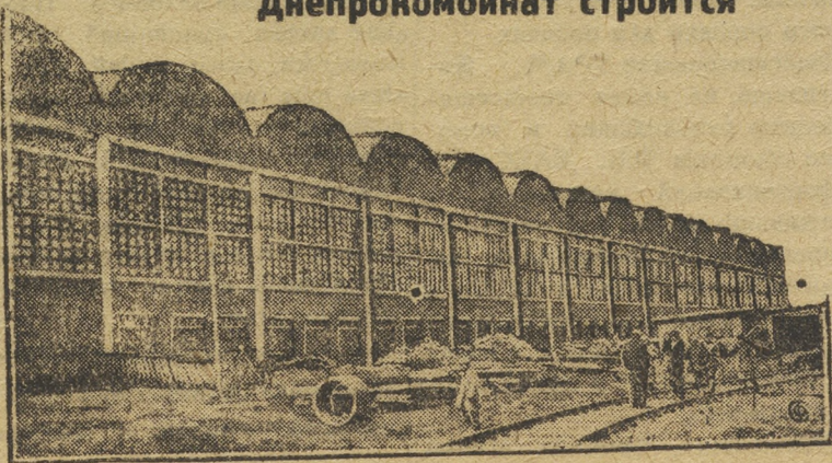
На снимке: фасад готовых цехов алюминиевого комбината
