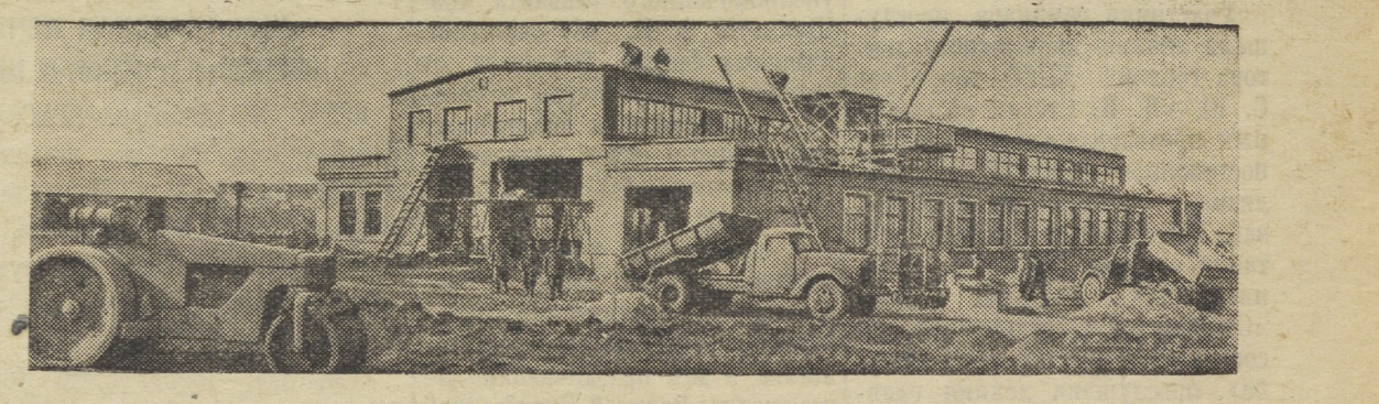
Московская область. В колхозах и МТС развернулось большое строительство. Сооружаются крупные теплицы и скотные дворы, силосные башни и другие хозяйственные постройки. Строятся новые усадьбы машинно-тракторных станций. На снимке: строительство новой усадьбы Донской машинно-тракторной станции. Фото Л. Поргера. Прессяппше ТАСС
