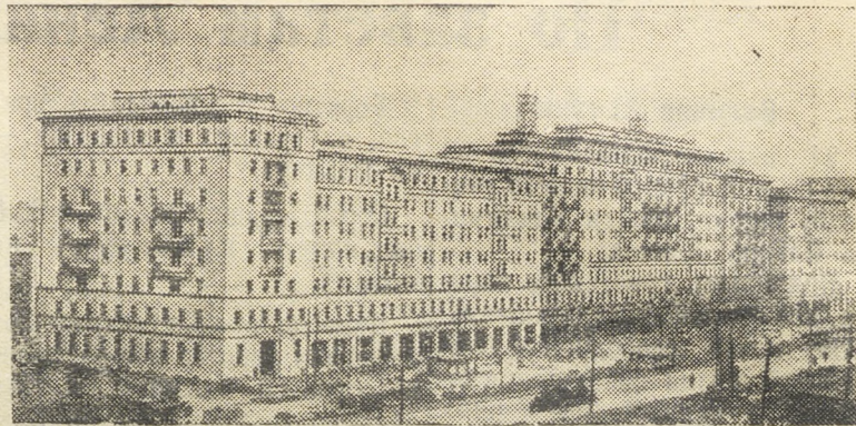
Германская Демократическая Республика. В Восточном Берлине на Аллее Сталина развернулось грандиозное строительство. Применяя передовые методы советских стахановцев, рабочие успешно соревнуются за досрочное окончание стройки. Многие здания готовы к сдаче в эксплуатацию.
