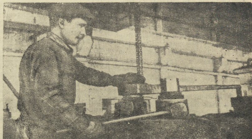
На снимке В. С. Потеряев — настройщик жестеотделочного цеха Северского завода. Хорошо следя за оборудованием, он систематически выполняет производственное задание на 115–120 процентов Снимок М. Просвирнина.
