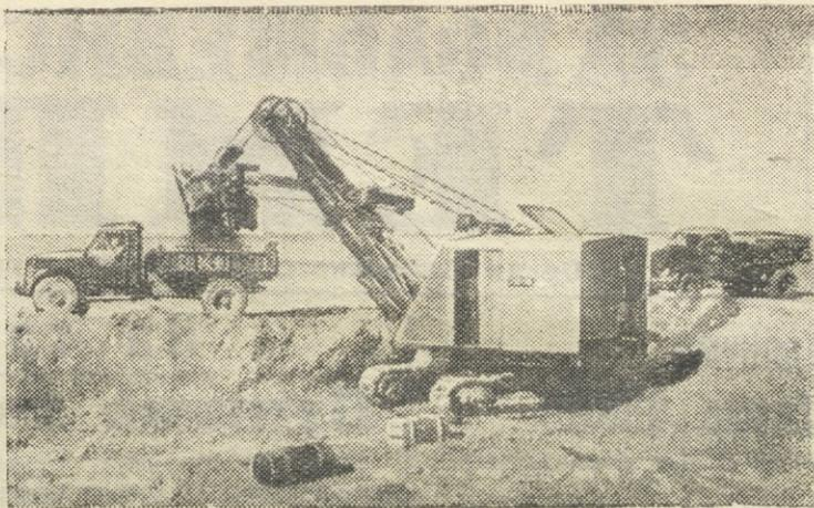
Сталинградская область. На левом берегу Волги полным ходом развернулись строительные работы. Началась прокладка самотечного канала Волга-Урал. Экскаваторы вынимают грунт из русла канала и грузят его на автомашины. Дальше грунт используется для возведения насыпи железнодорожной ветки к площадке строительства Сталинградской ГЭС.
