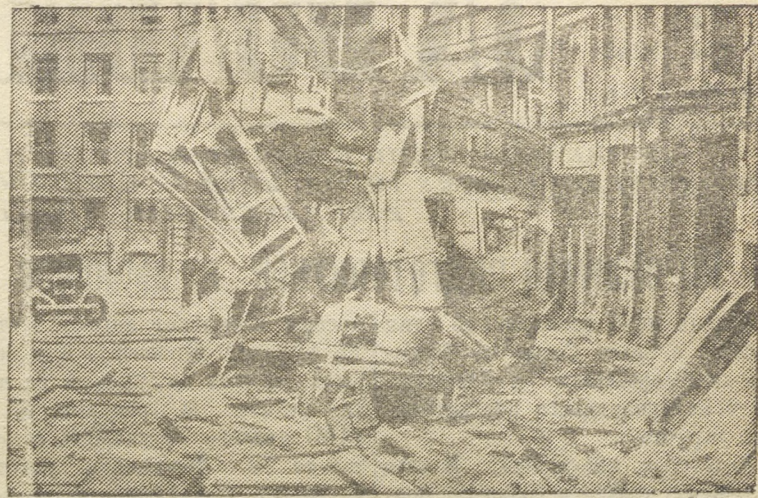
Разрушения на улицах Лондона в результате бомбардировки германской авиацией.
