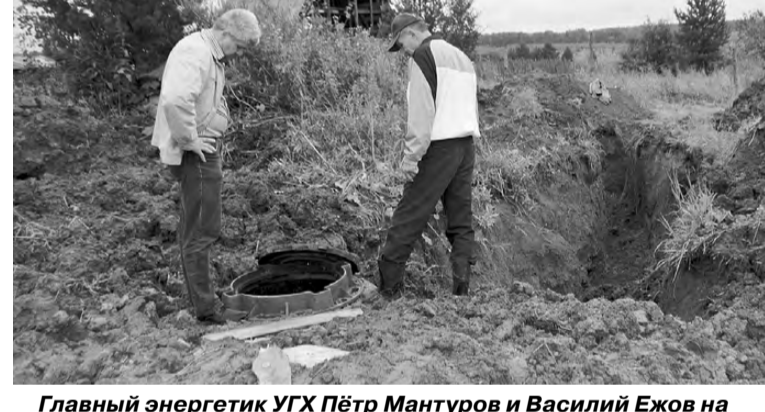
Главный энергетик УГХ Пётр Мантуров и Василий Ежов на приёмке нового водопровода. Запорная арматура находится в этом колодце и скрыта от глаз водой. Что стало причиной затопления: дожди или очередной порыв, пока не ясно.
