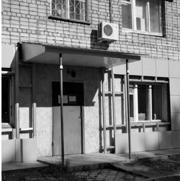
На днях начнётся монтаж окон.
