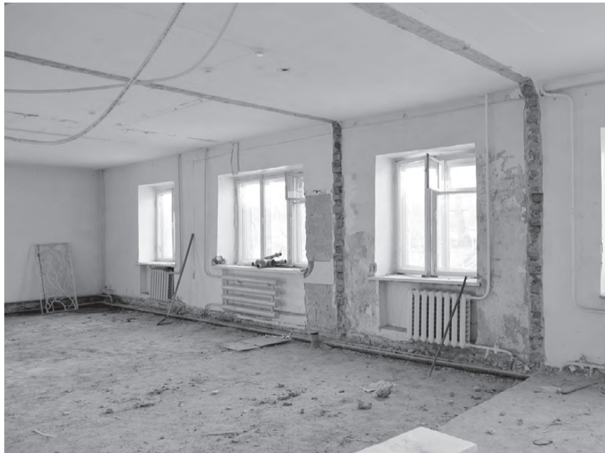
В помещениях проводится капитальный ремонт.
