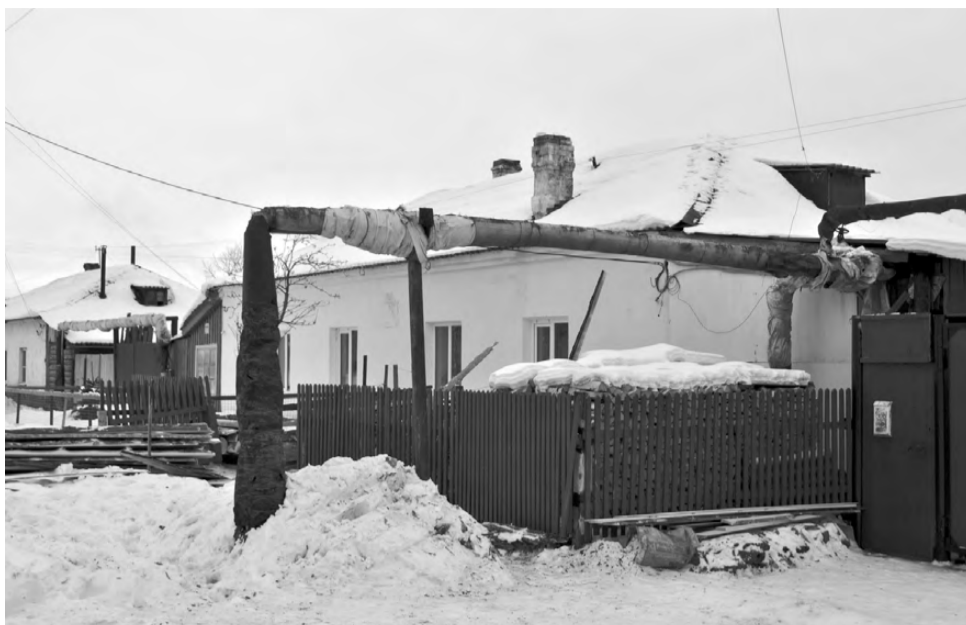
Трубы кочневцы утепляют подручными средствами.
