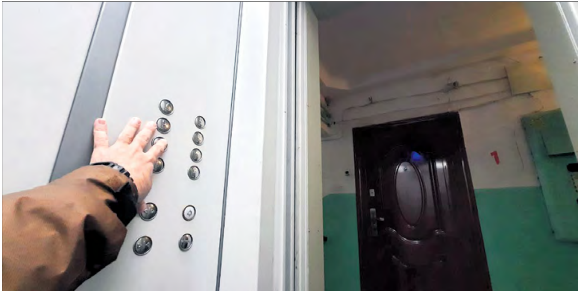
Примерно так будут выглядеть внутри сразу 11 лифтов Ревды, которые в этом году удастся поменять на новые. // Фото Владимира Коцюбы-Белых
