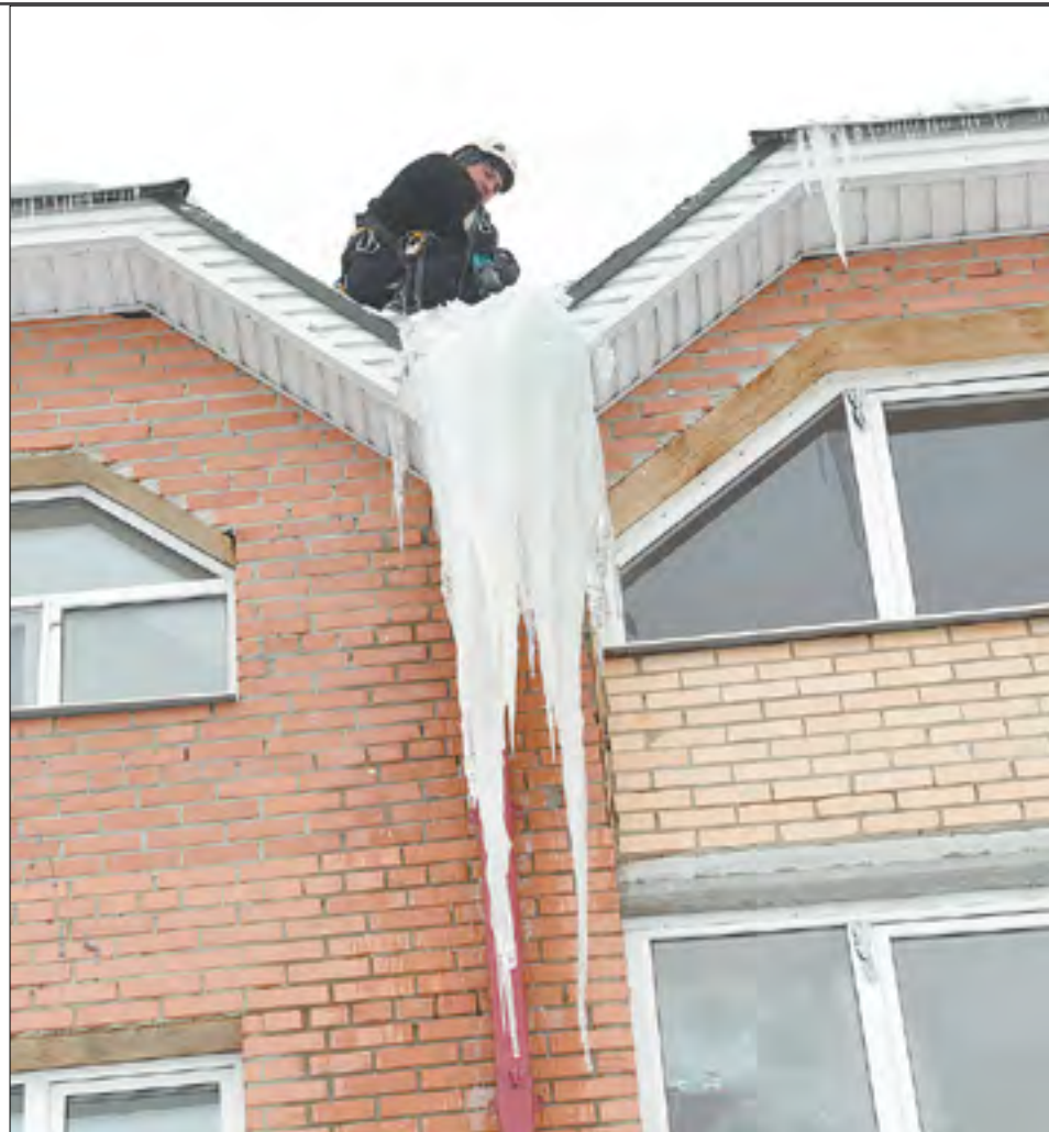
Вот так работают высотники — на Интернационалистов, 42 огромные сосульки нарастают там, куда автовышке подобраться невозможно. Приходится действовать вручную, перфоратором. • Фото Владимира Коцюбы-Белых
