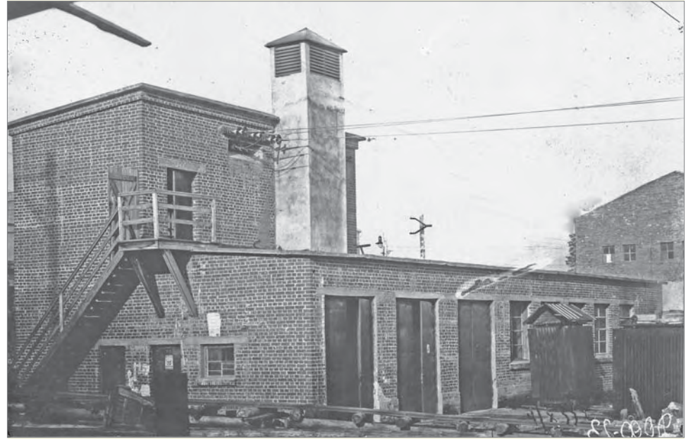
Первая подстанция завода, пуск состоялся в мае 1932 года.
