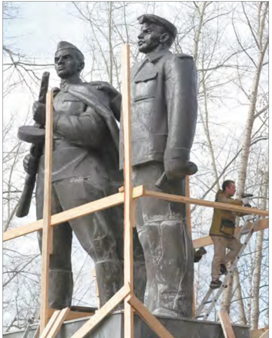
После того, как сняли краску, на ногах фигур стали заметны глубокие трещины. // Фото Владимира Коцюбы-Белых
