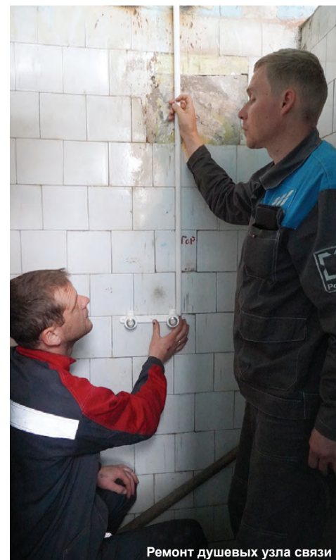
Ремонт душевых узлов связи
