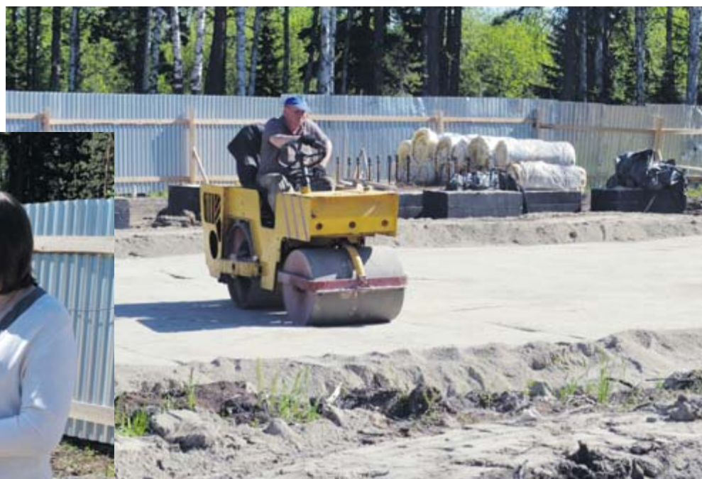
Рабочий на катке уплотняет основание под котельную
