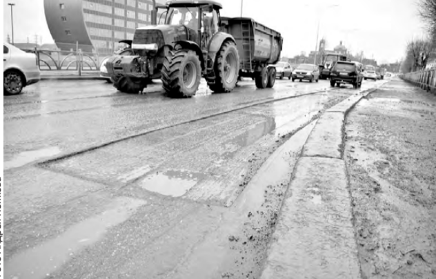
Улица Орджоникидзе: отфрезеровали, при сухой погоде — заасфальтируют
