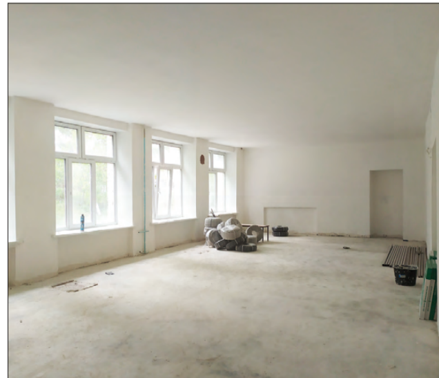
Продолжаются ремонтные работы в школе №30
