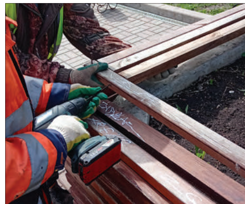
На улице Трояна восстановительные работы начались ещё до обследования: меняются люки, деревянные конструкции, на очереди – приведение в порядок бетонных клумб и замена плитки
