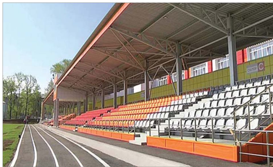
После реконструкции его не узнать. 2018 год.
