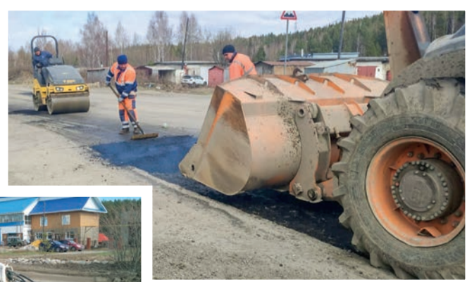
Ямочный ремонт дороги на улице Районная
