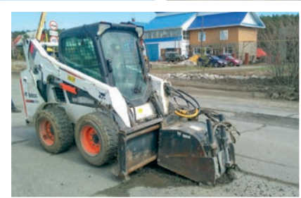
Ямочный ремонт дороги на улице Районная
