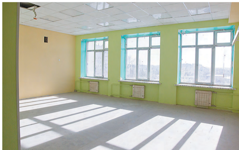
Внутренняя отделка практически выполнена.
