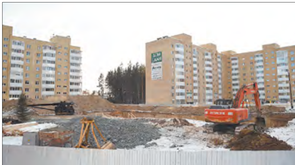
Строители начали готовить котлован под фундамент будущего дома. • Фото Владимира Коцюбы-Белых
