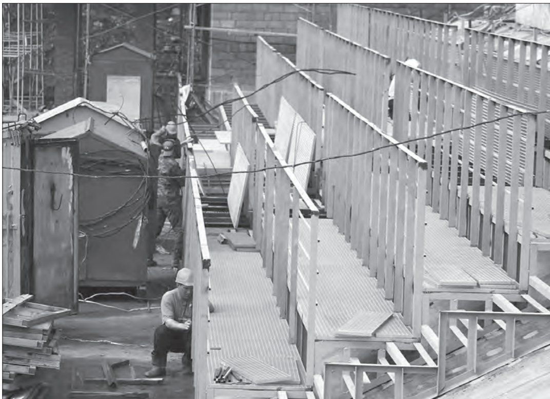
Идет монтаж новых трибун. ФОТО АВТОРА.
