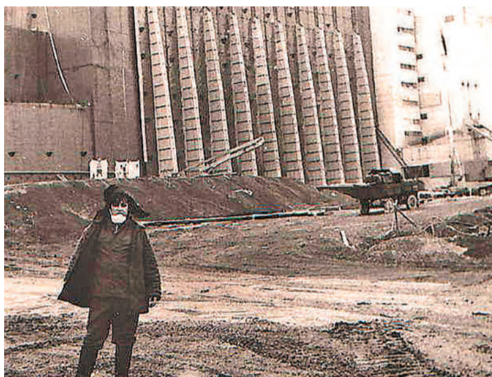
На заднем плане – «рёбра» саркофага для блока № 4 ЧАЭС (ноябрь 1986 года).
