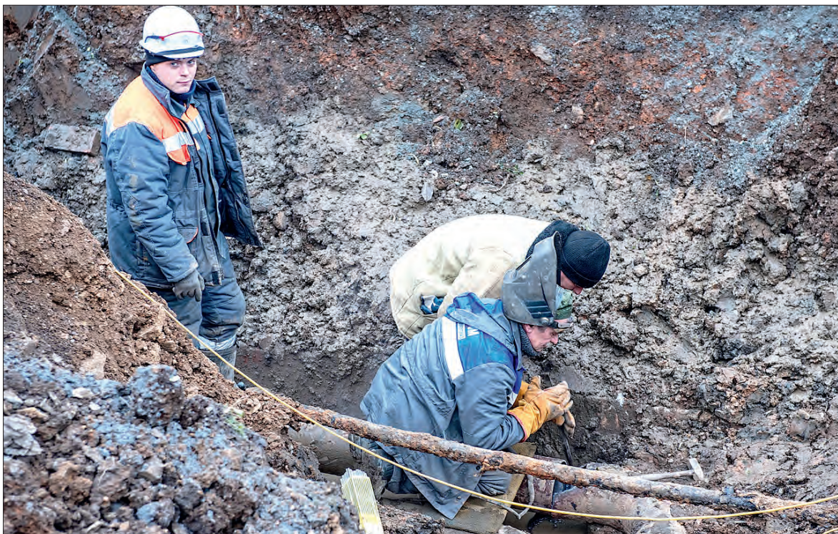
Подразделение «Тепловые сети г. Нижняя Тура» Свердловского филиала «Т Плюс» приступило к работе в муниципалитете с 15 октября. Сейчас идет замена труб на проблемных участках. Так, 10 ноября устранялись повреждения на теплосетях в районе дома № 1 на улице Парковой / ФОТО СЕРГЕЯ ЧИКИШЕВА
