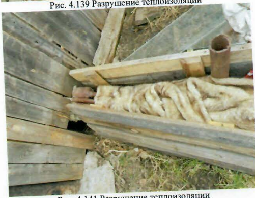
Рис. 4.141 Разрушение теплоизоляции
