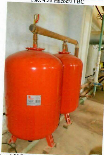
Рис. 4.28 Баки мембранные расширительные
