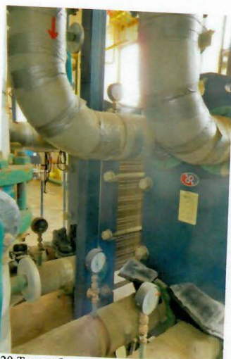
Рис. 4.29 Теплообменники отопления пластинчатые
