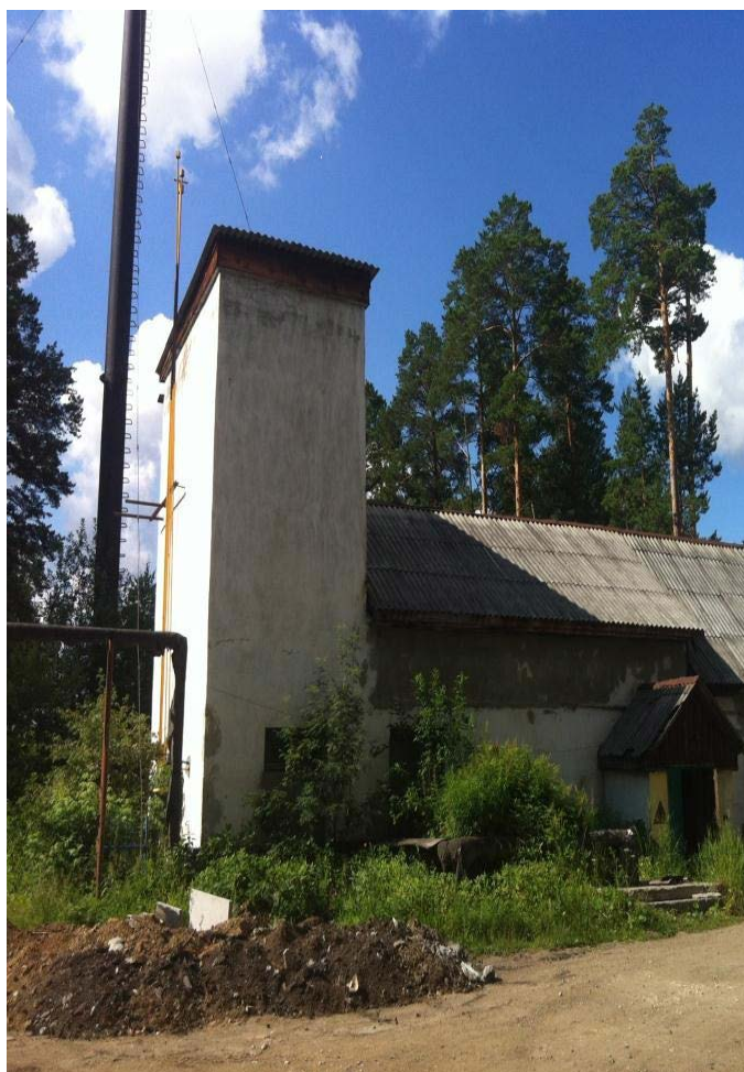
Газовая котельная п. Верхняя Сысерть.
