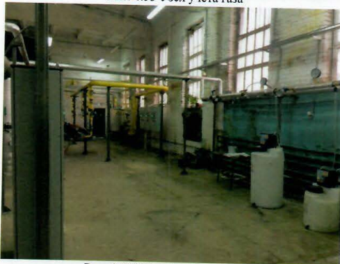
Рис. 4.55 Общий вид котельной
