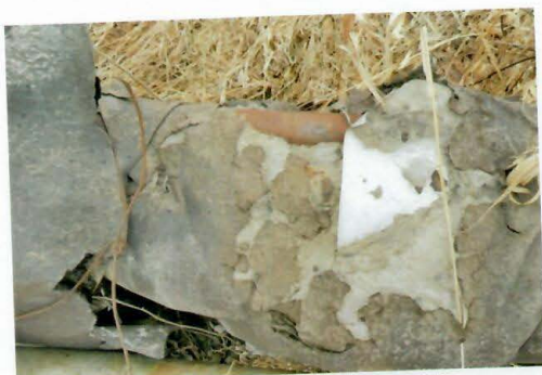
Рис. 4.133 Разрушение теплоизоляции
