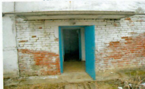
Рис. 4.114 Вход в здание котельной
