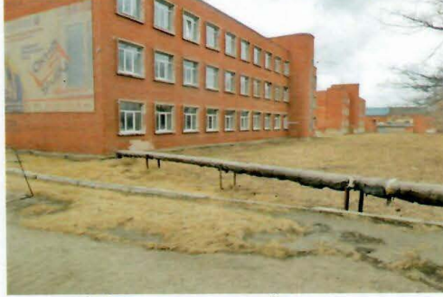
Рис. 4.106 Надземная теплотрасса. Ввод в здание училища
