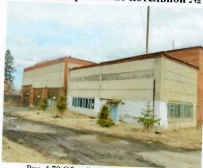
Рис. 4.79 Общий вид здания котельной
