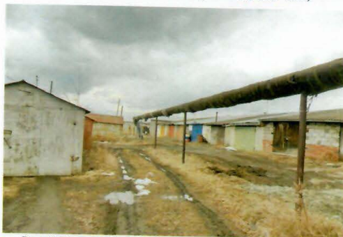
Рис. 4.59 Надземный участок магистральной теплосети
