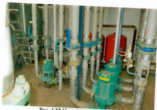
Рис. 4.27 Насосы рециркуляции
