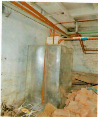
Рис. 4.23 Ёмкость под дизтопливо (не используется)
