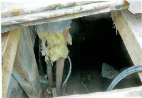
Рис. 4.101 Колодец магистральный тепловой сети
