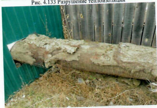
Рис. 4.135 Разрушение теплоизоляции
