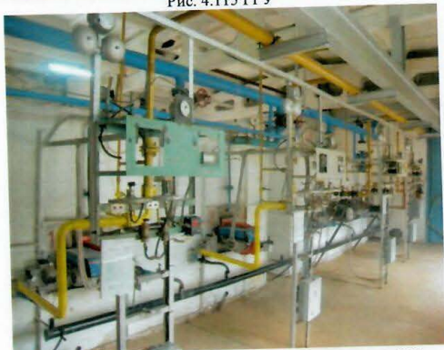
Рис. 4.117 Котлы водогрейные с газовыми горелками
