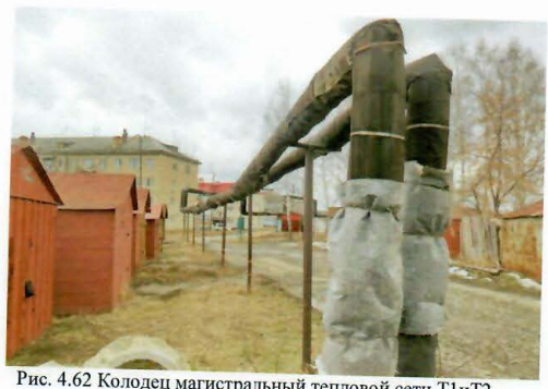
Рис. 4.61 П-образные переходы магистрали теплосети над проезжей частью
