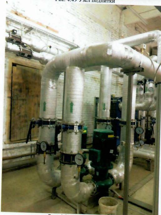
Рис. 4.51 Сетевые насосы
