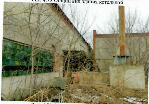
Рис. 4.81 Основание дымовой трубы
