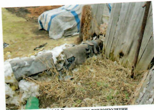
Рис. 4.140 Разрушение теплоизоляции
