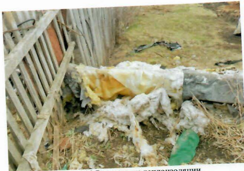
Рис. 4.139 Разрушение теплоизоляции
