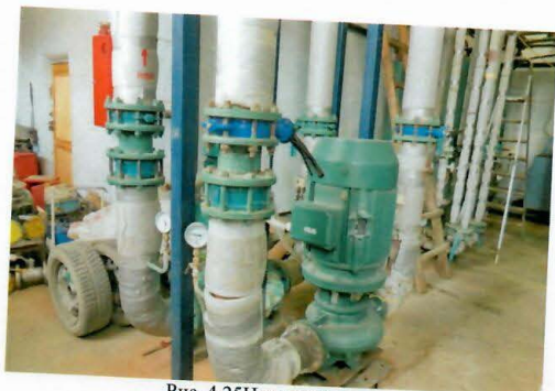
Рис. 4.25 Насосы сетевые
