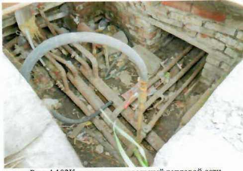
Рис. 4.102 Колодец магистральный тепловой сети
