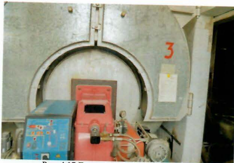
Рис. 4.17 Горелка газодизельная Unigas
