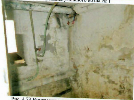
Рис. 4.73 Внутренняя стена здания котельной
