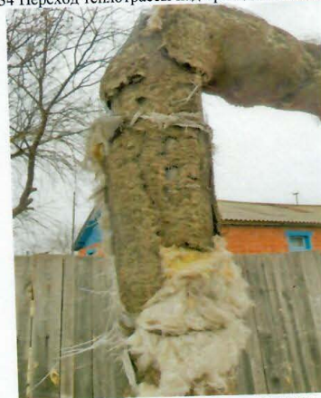
Рис. 4.136 Разрушение теплоизоляции
