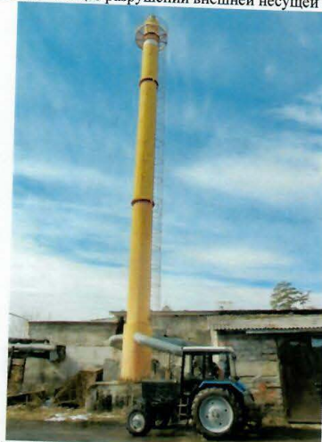
Рис. 4.12 Дымовая труба (установлена в 2006г.)
