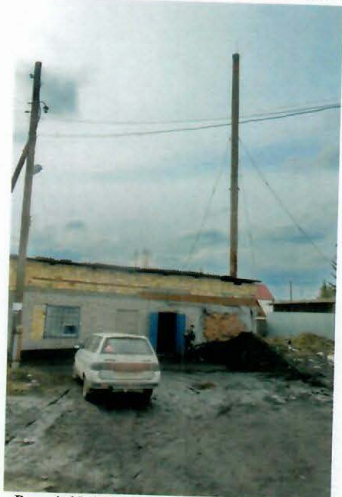
Рис. 4.65 Общий вид здания котельной
