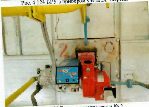
Рис. 4.126 Газовая горелка котла № 2
