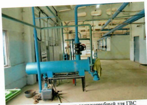
Рис. 4.123 Теплообменник кожухотрубный для ГВС
