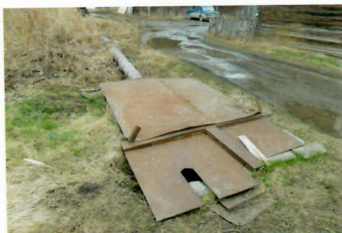
Рис. 4.99 Колодец магистральный тепловой сети
