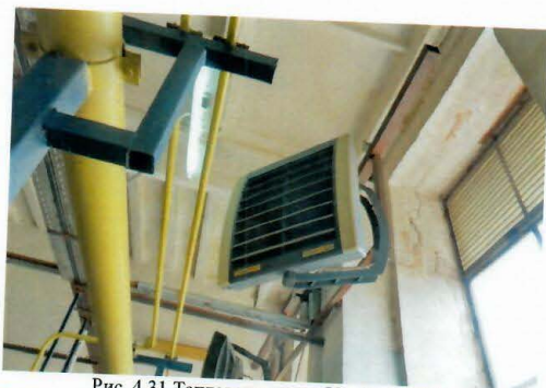
Рис. 4.31 Тепловентилятор Voolcano VR1
