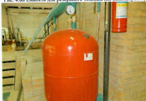
Рис. 4.90 Мембранный бак расширительный 200л
