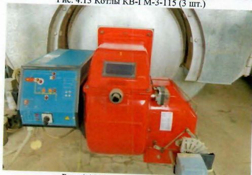
Рис. 4.15 Горелка газовая Unigas
