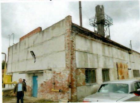
Рис. 4.107 Общий вид здания котельной
