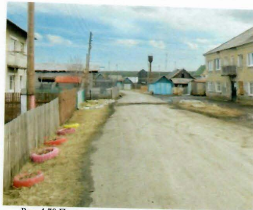
Рис. 4.78 Подземная теплотрасса, проход под дорогой
