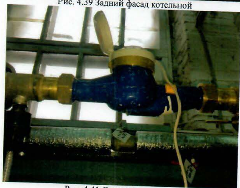
Рис. 4.41 Счетчик подпитки
