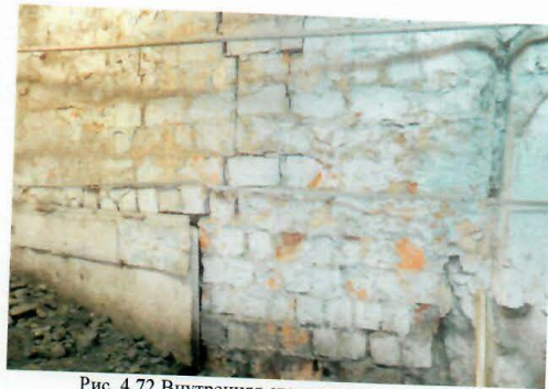
Рис. 4.72 Внутренняя стена здания котельной
