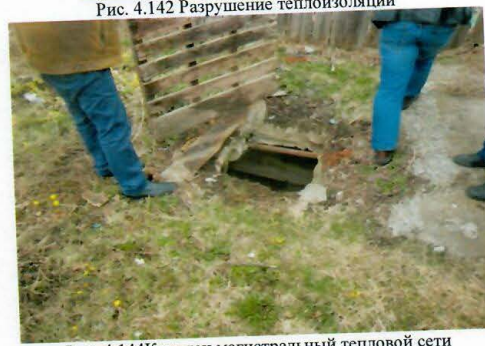
Рис. 4.144 Колодец магистральный тепловой сети
