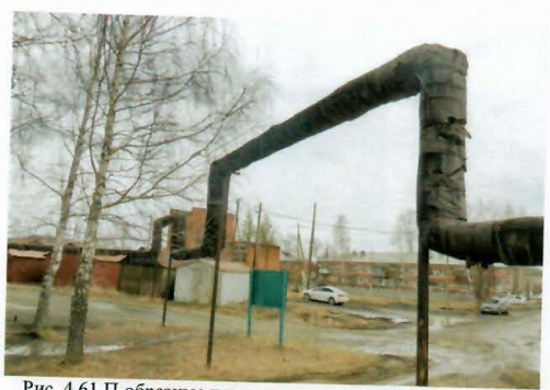
Рис. 4.61 П-образные переходы магистрали теплосети над проезжей частью
