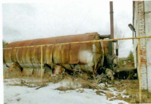
Рис. 4.108 Цистерны для воды 2x50 куб.м. (не используются)
