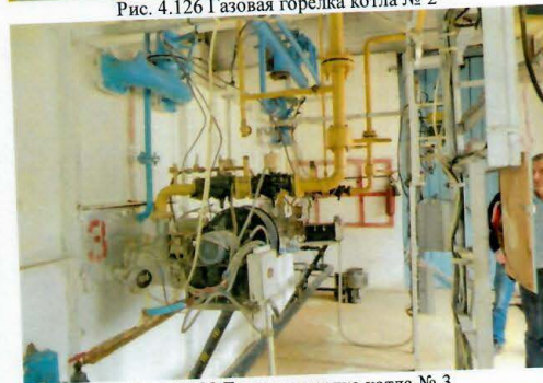
Рис. 4.128 Газовая горелка котла № 3
