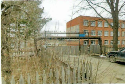
Рис. 4.105 Въезд на территорию училища к котельной
