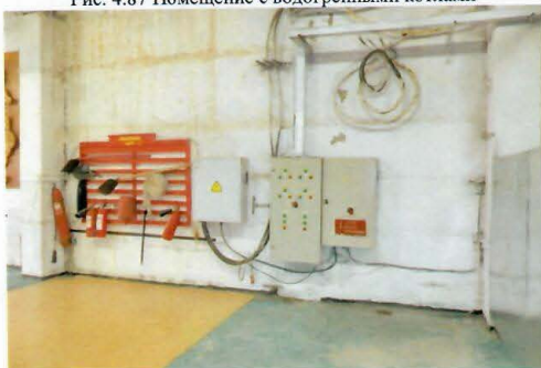
Рис. 4.89 Шкафы управления и учета
