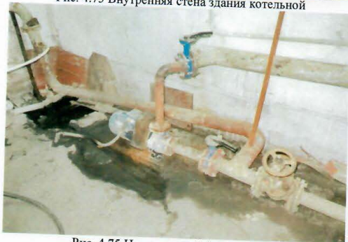
Рис. 4.75 Насос сетевой 1 (основной)
