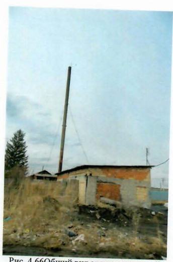
Рис. 4.66 Общий вид здания котельной
