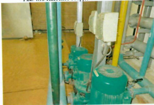
Рис. 4.95 Сетевые насосы
