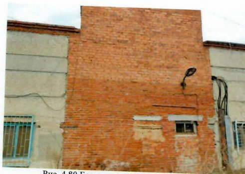
Рис. 4.80 Боковая стена здания котельной
