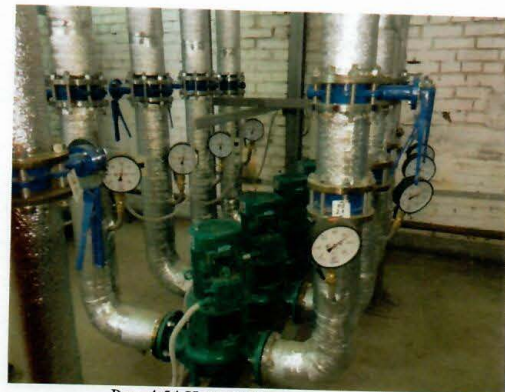
Рис. 4.54 Насосы рециркуляции
