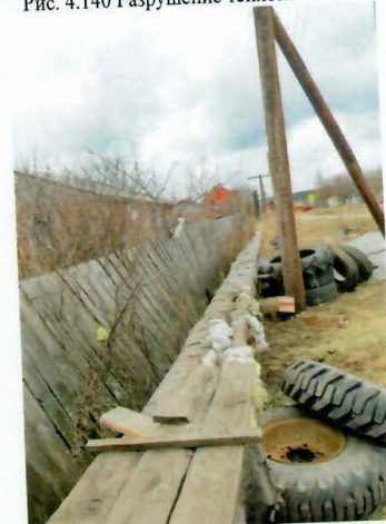
Рис. 4.142 Разрушение теплоизоляции
