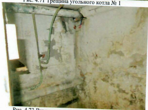
Рис. 4.73 Внутренняя стена здания котельной
