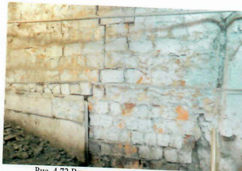
Рис. 4.72 Внутренняя стена здания котельной
