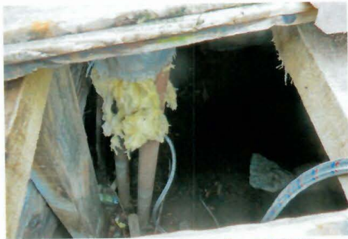
Рис. 4.101 Колодец магистральный тепловой сети
