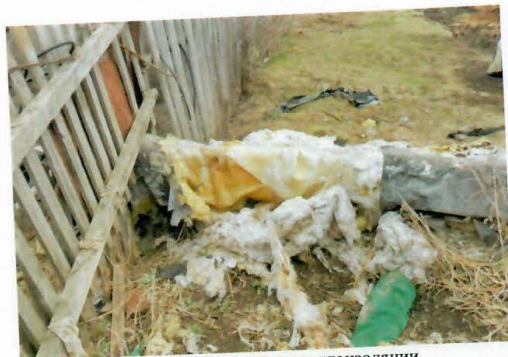
Рис. 4.139 Разрушение теплоизоляции
