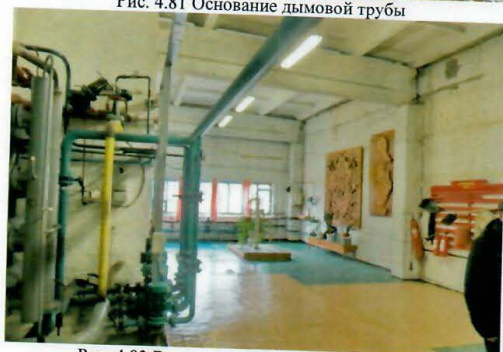
Рис. 4.83 Внутреннее помещение котельной
