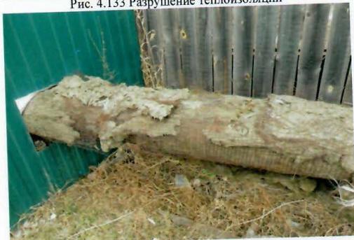
Рис. 4.135 Разрушение теплоизоляции
