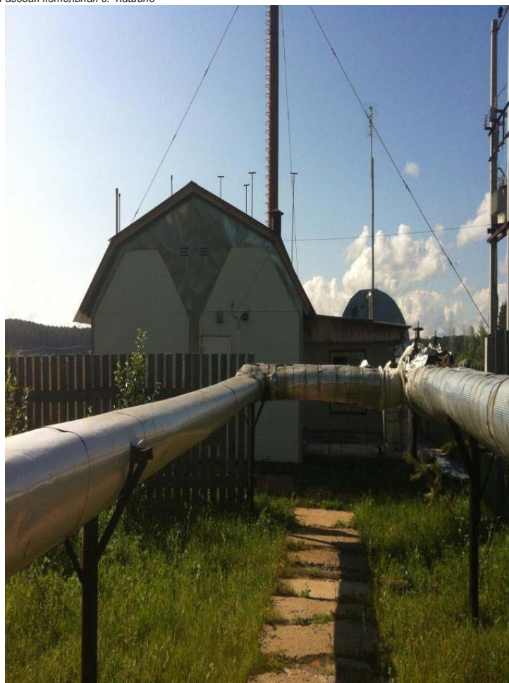
Газовая котельная с. Кашино
