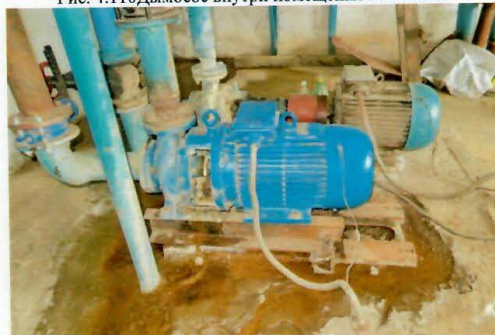
Рис. 4.112 Насосы сетевые
