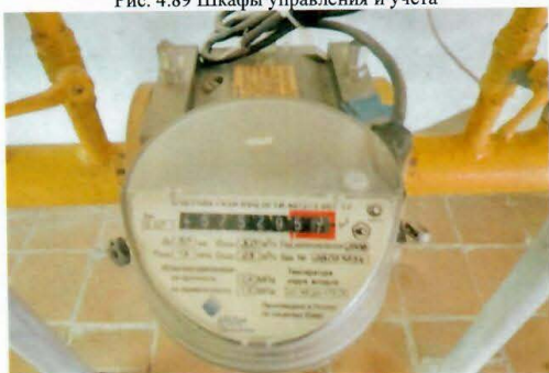
Рис. 4.91 Счетчик газа
