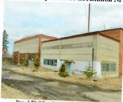
Рис. 4.79 Общий вид здания котельной
