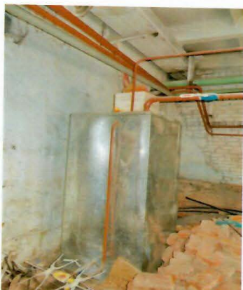
Рис. 4.23 Ёмкость под дизтопливо (не используется)
