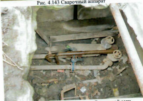
Рис. 4.145 Колодец магистральный тепловой сети
