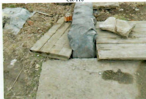
Рис. 4.100 Колодец магистральный тепловой сети
