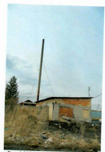
Рис. 4.66 Общий вид здания котельной
