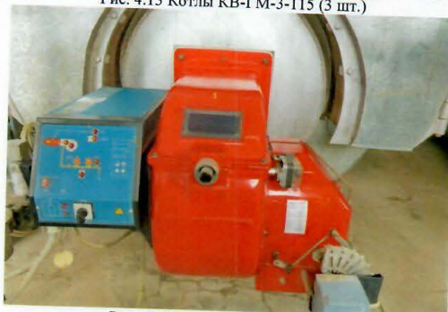
Рис. 4.15 Горелка газовая Unigas
