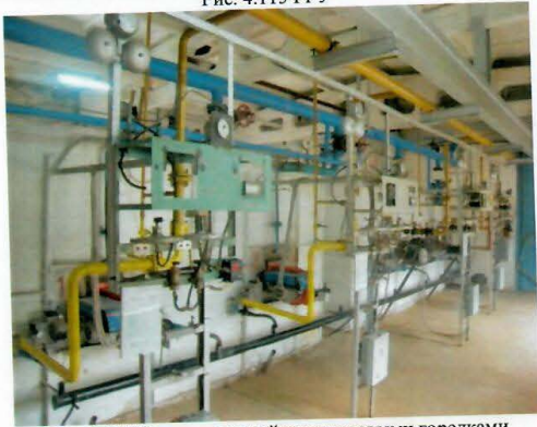
Рис. 4.117 Котлы водогрейные с газовыми горелками
