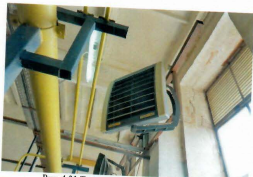
Рис. 4.31 Тепловентилятор Voolcano VRI
