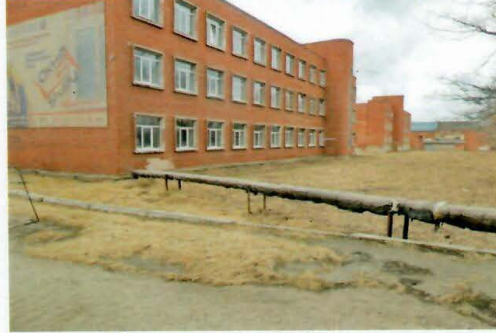
Рис. 4.106 Надземная теплотрасса. Ввод в здание училища
