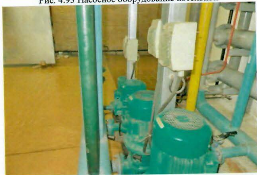
Рис. 4.95 Сетевые насосы
