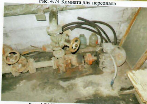
Рис. 4.76 Насос сетевой 2 (неисправен)
