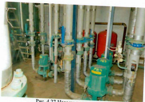
Рис. 4.27 Насосы рециркуляции
