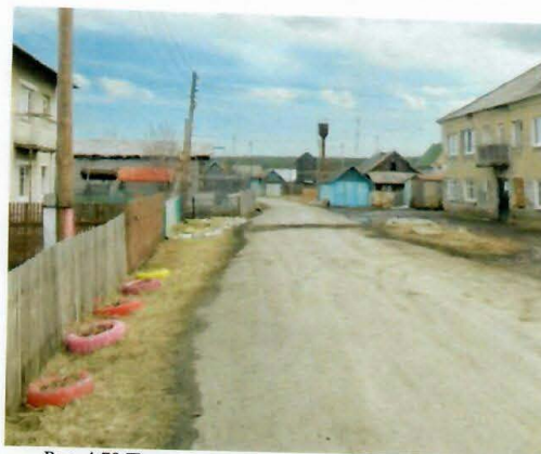
Рис. 4.78 Подземная теплотрасса, проход под дорогой
