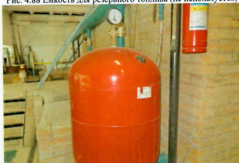
Рис. 4.90 Мембранный бак расширительный 200л
