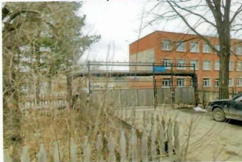
Рис. 4.105 Въезд на территорию училища к котельной
