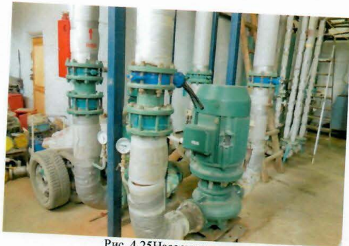
Рис. 4.25 Насосы сетевые
