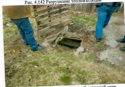
Рис. 4.144 Колодец магистральный тепловой сети
