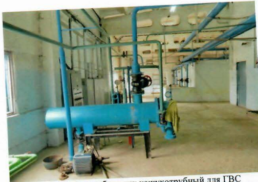
Рис. 4.123 Теплообменник кожухотрубный для ГВС
