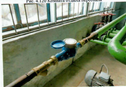
Рис. 4.122 Счетчик воды
