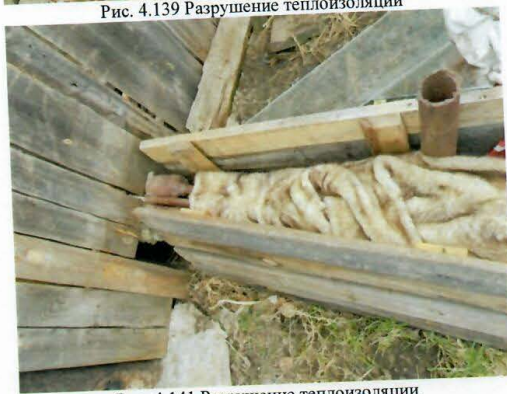
Рис. 4.141 Разрушение теплоизоляции
