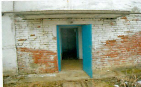
Рис. 4.114 Вход в здание котельной
