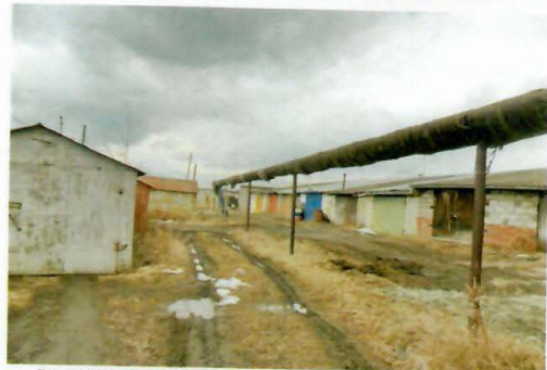
Рис. 4.59 Надземный участок магистральной теплосети
