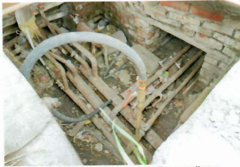
Рис. 4.102 Колодец магистральный тепловой сети
