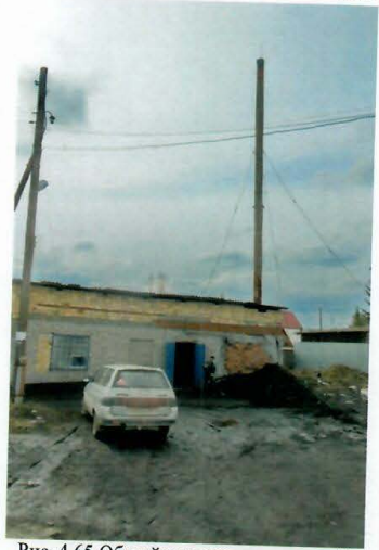
Рис. 4.65 Общий вид здания котельной
