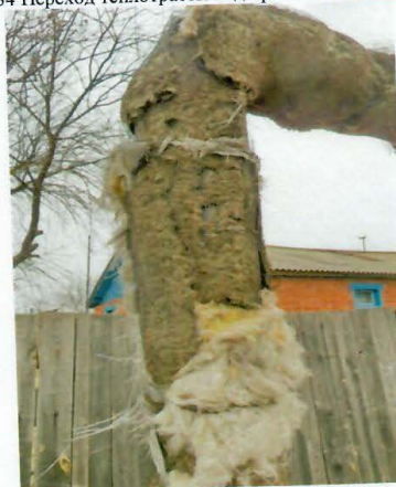
Рис. 4.136 Разрушение теплоизоляции
