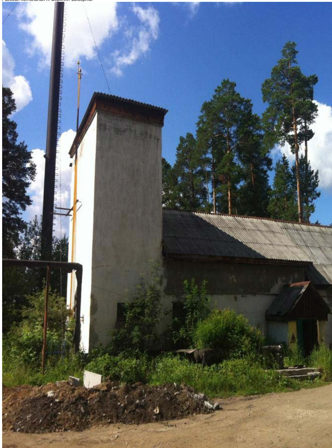
Газовая котельная п. Верхняя Сысерть.
