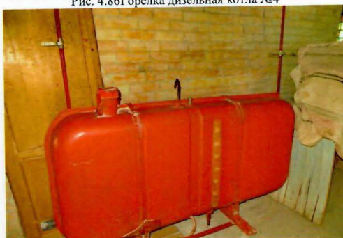
Рис. 4.88 Емкость для резервного топлива (не используется)
