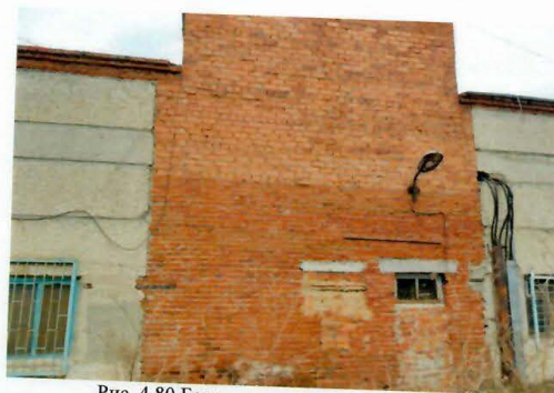
Рис. 4.80 Боковая стена здания котельной
