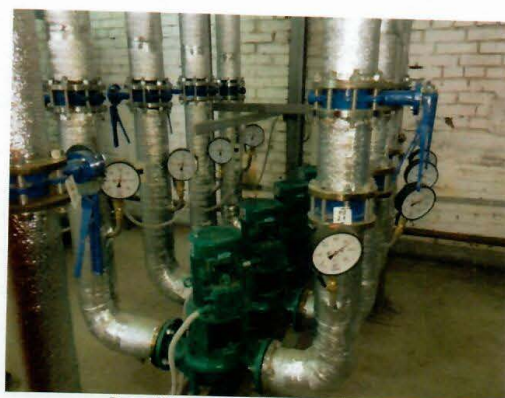
Рис. 4.54 Насосы рециркуляции
