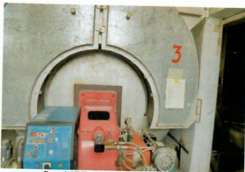
Рис. 4.17 Горелка газодизельная Unigas
