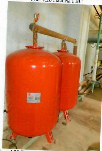
Рис. 4.28 Баки мембранные расширительные
