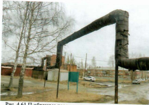
Рис. 4.61 П-образные переходы магистрали теплосети над проезжей частью
