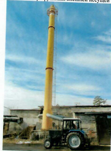
Рис. 4.12 Дымовая труба (установлена в 2006г.)
