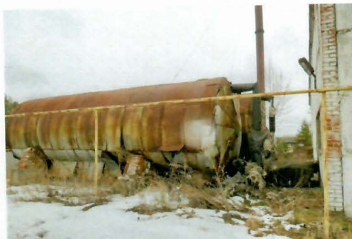
Рис. 4.108 Цистерны для воды 2х50 куб.м. (не используются)
