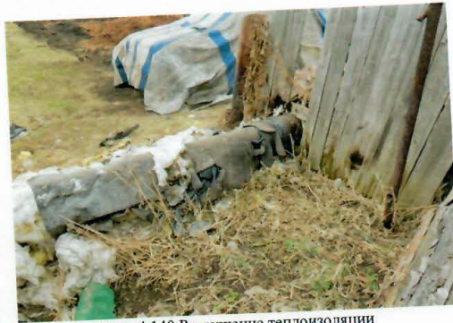
Рис. 4.140 Разрушение теплоизоляции
