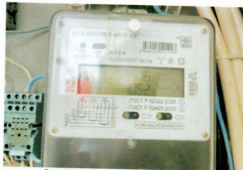
Рис. 4.18 Прибор учета электроэнергии
