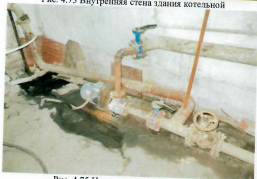
Рис. 4.75 Насос сетевой 1 (основной)
