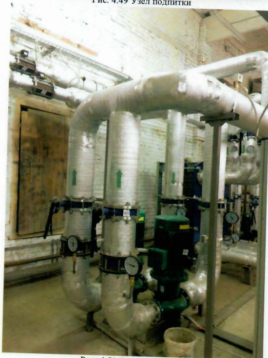
Рис. 4.51 Сетевые насосы
