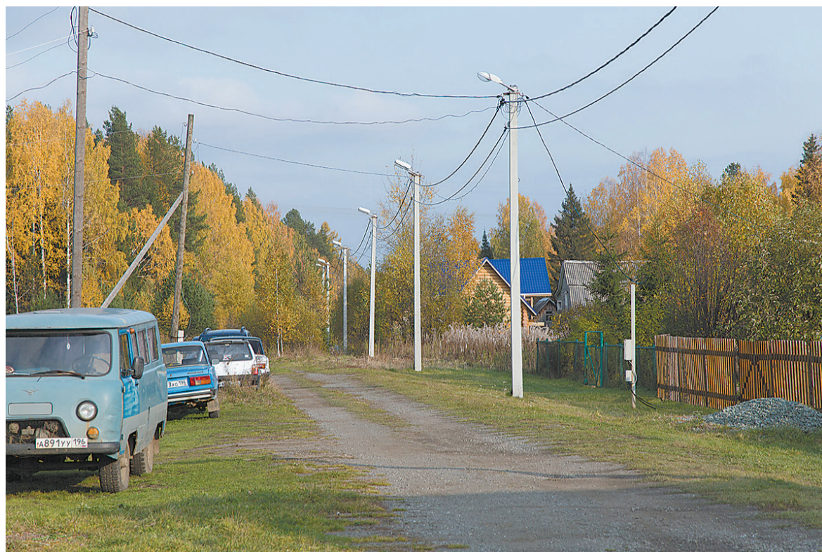
Линии проложены так, чтобы не мешать проезду.
