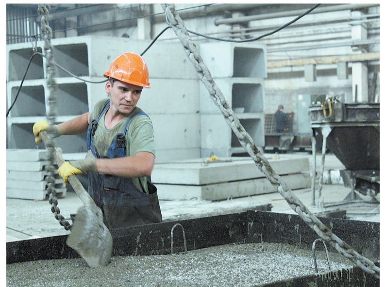
Важно равномерно распределить бетон в форме.
