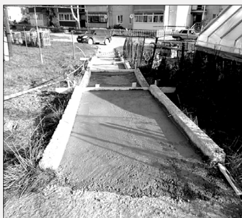
Жители села своими силами забетонировали ступенчатый тротуар на улице Урицкого
