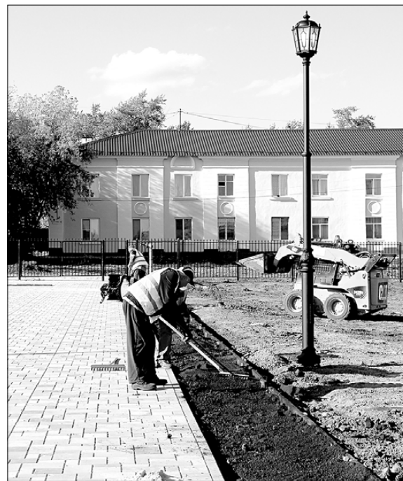
Работы по устройству пешеходных дорожек и клумб в парке-дендрарии, запланированные на следующий год, будут завершены раньше срока
